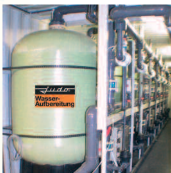
Filterstufe Meerwasserentsalzung
