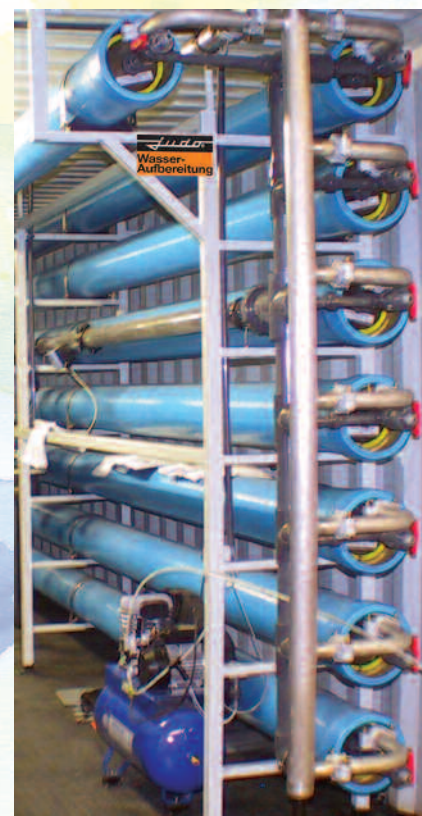
Membranrack Meerwasserentsalzungsanlage
