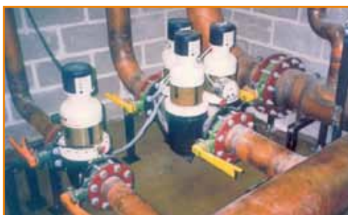
Trinkwasserfiltration durch JPF-ATP DN 100 und DN 150 Olympisches Dorf, Sydney
