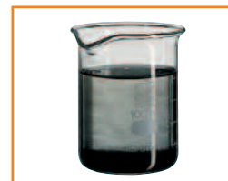
Schlamm aus einer alten Heizungsanlage.
