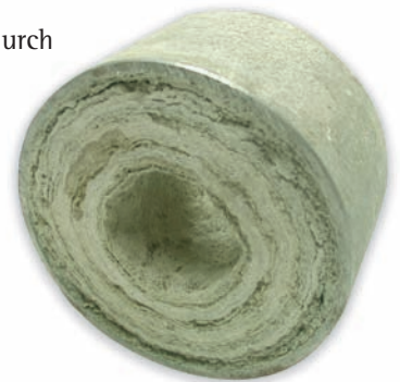
Kalkablagerungen in einem Wasserrohr
