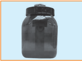
Eau de circuit remplie de boue.
